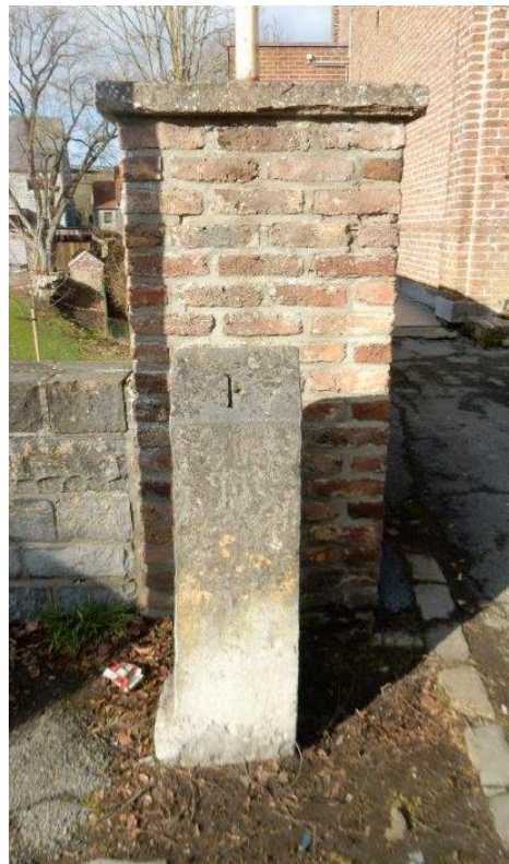
A l'entrée de la maison communale (grand rue)
